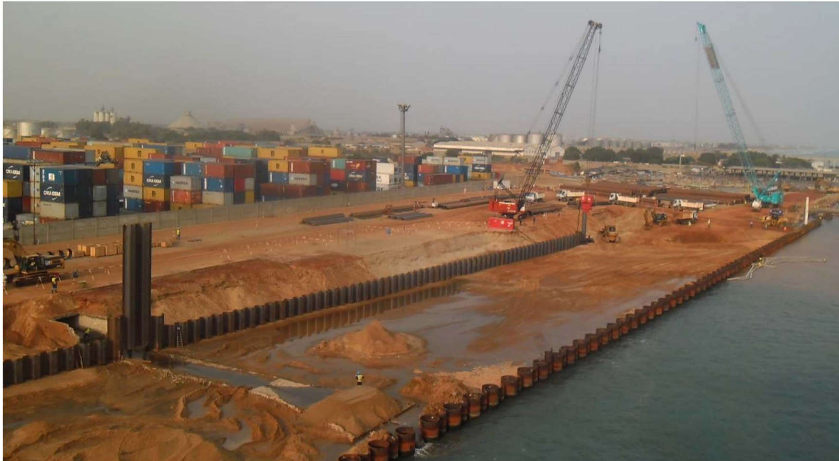
Mur de quai et rideau d'ancrage : Avant la pose des tirants
