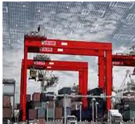
ASCs, RTGs & RMGs
