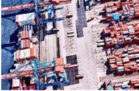
Container Terminal Altenwerder
