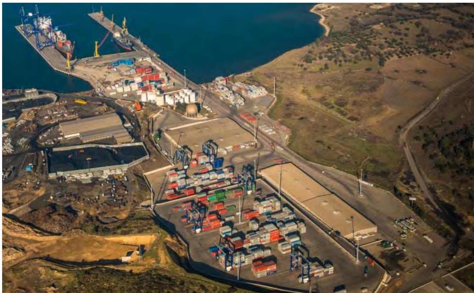
TCE EGE Container Terminal
